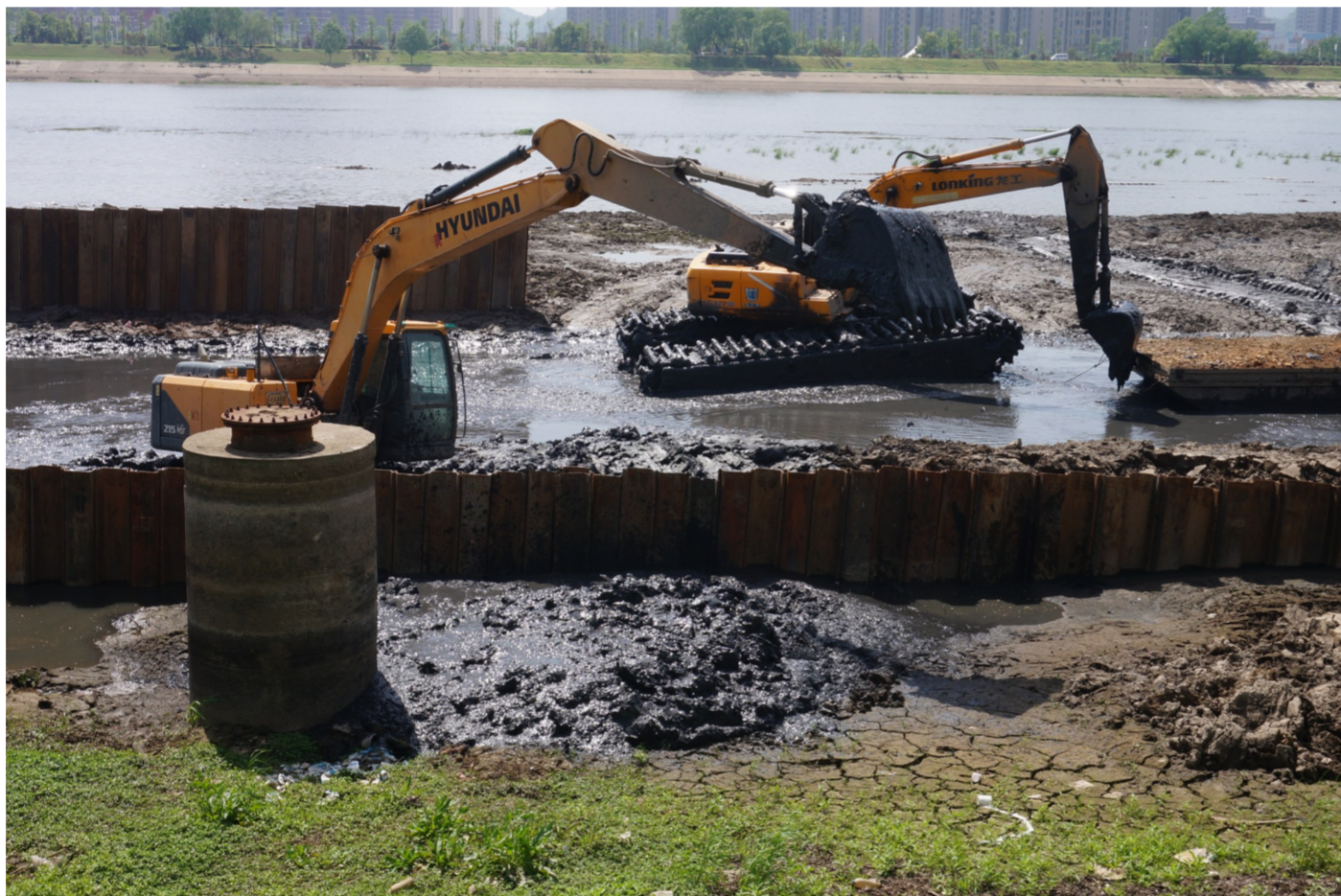
19日,在大冶湖青龙塔至大冶湖三桥之间,大型设备正在河床上进行污水管网铺设。施工设备开挖沟槽,然后再铺设污水管道,实现污水和雨水分流,改善大冶湖水水质环境,提升人居环境。 通讯员 瞿泽敏 摄
